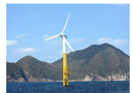
2MW実機の1/2モデル 実海域実証試験
